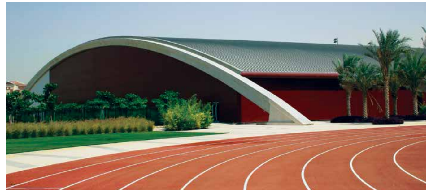
Dubai Sports City, Emirati Arabi Uniti Architetto: Godwin Austen Johnson
